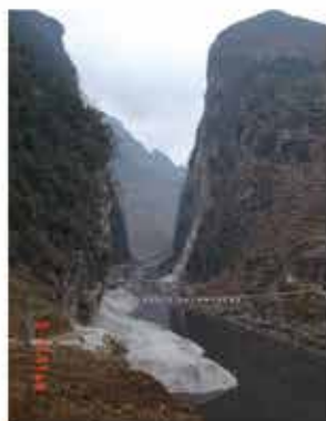
开挖前坝址位置下游图片
