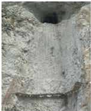
开挖完成后右坝肩图片
