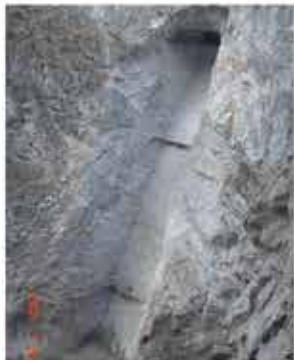
开挖完成后左坝肩图片
