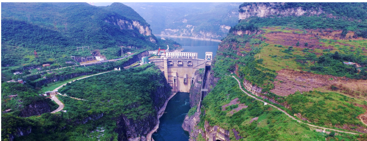
图 | 乌江东风水电站大坝
